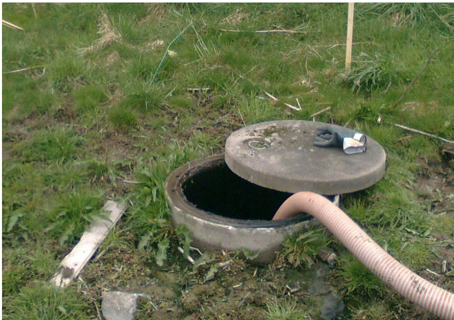
Tett tank som har rent over, og hvor eier tømmer selv. Foto:SSIØ
